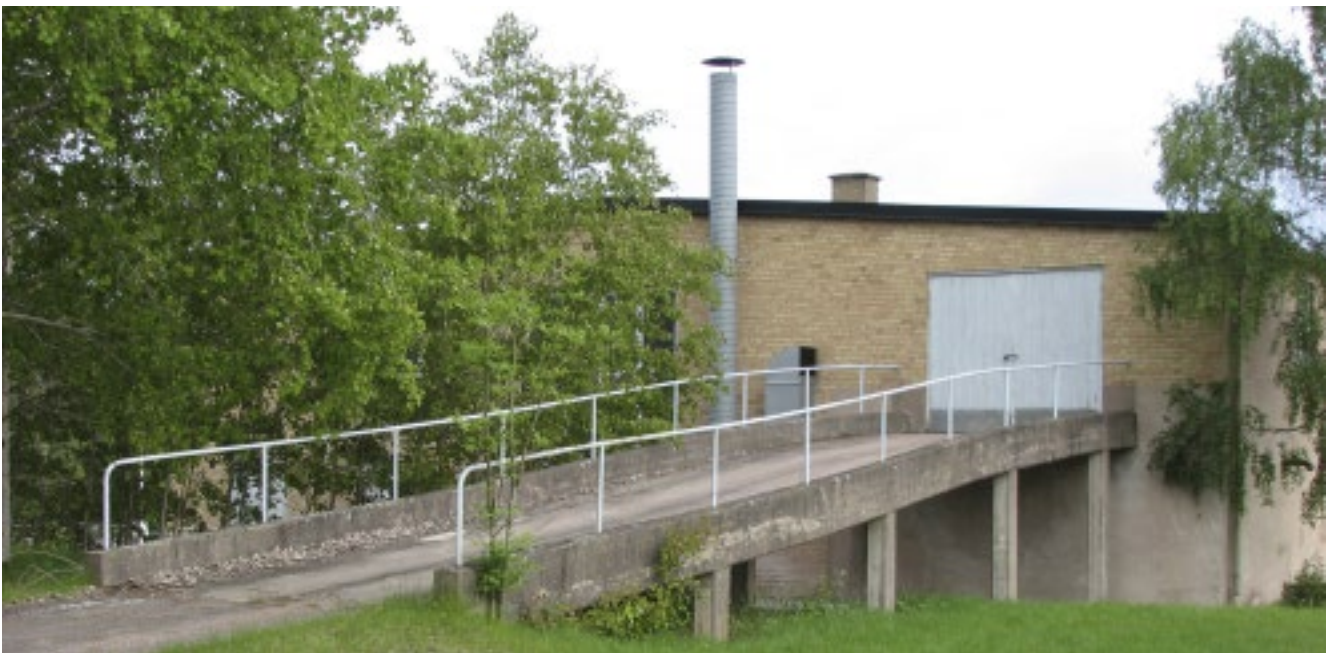
Rampen till mängkammarens sandbinge.
