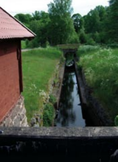
Elverket från 1914 och vattenrännan.
